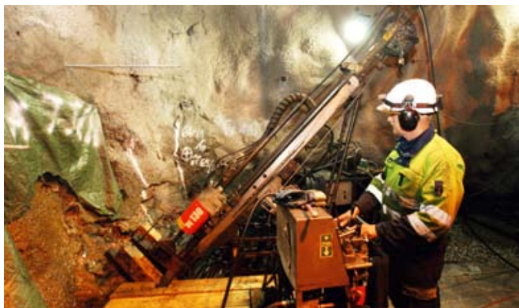
Borrning under jord i Malmberget åt LKAB.
