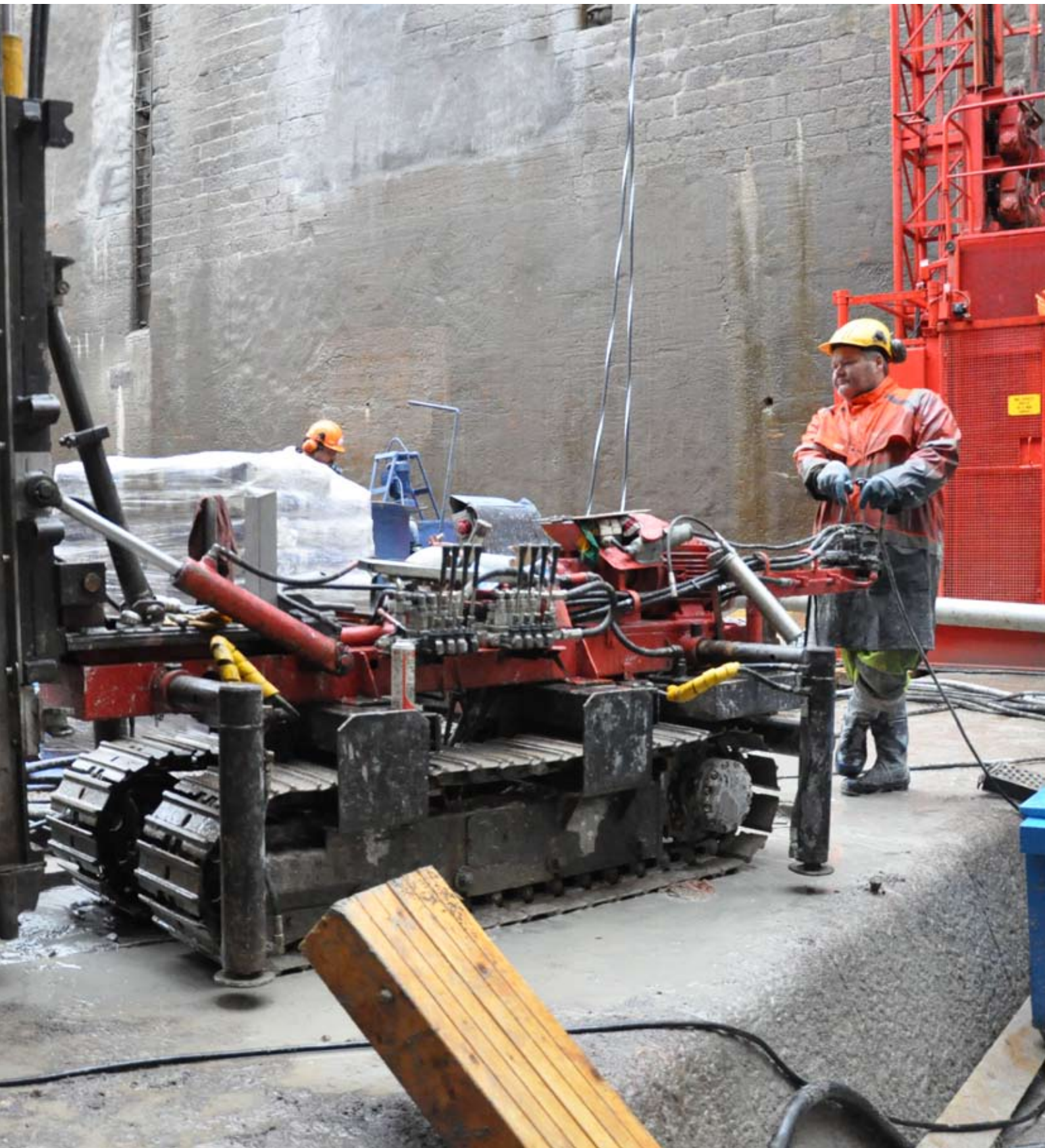
Uppställning av borrhög i Trollhätte Slussar.
